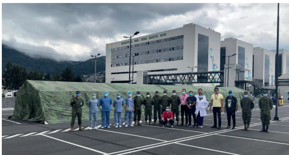
Figura 6. Instalación de carpas climatizadas en el hospital del IESS del Sur, para atención de pacientes COVID-19 Nota. Archivo fotográfico autorizado de OPSIC C.O 4 "CENTRAL"
