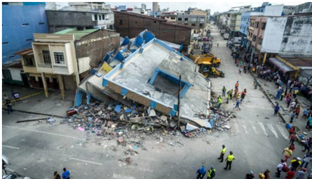
Figura 1. Edificación colapsada en sismo producido en Ecuador, 2016.
