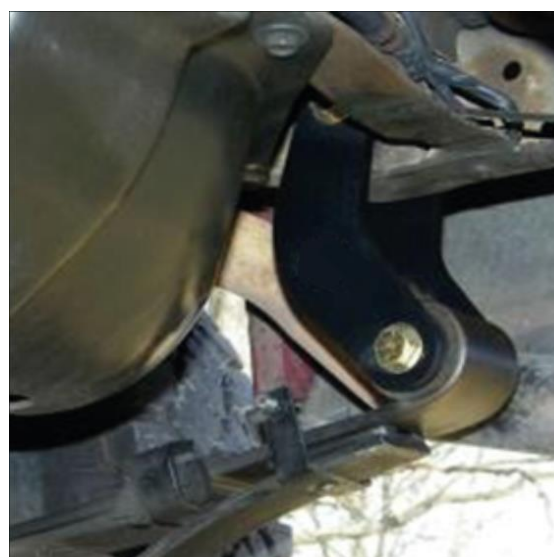
Fig. 20. Instalación del elemento perfeccionado
