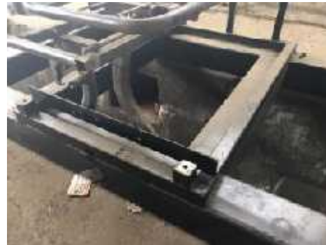
Figura 10. Anclaje del JIG a la estructura del banco
