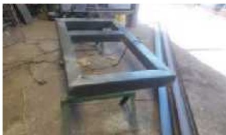
Figura 8. Base de la estructura con perfiles cuadrados
