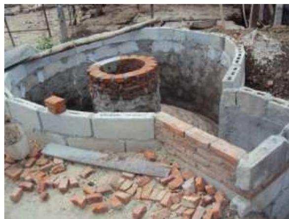
**Fig. 3 Biodigestor**
