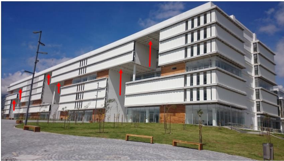
Figura 6 Pisos suspendidos de la Plataforma Gubernamental Social en la parte superior en planos y en la parte inferior completamente construidos.
