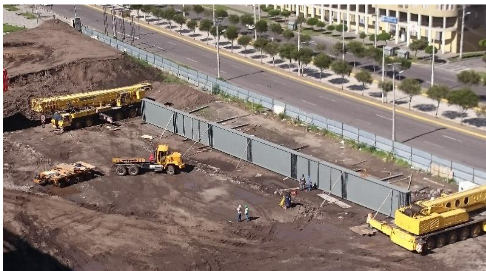
Figura 3 Imagen de una de las 10 vigas-puente alojada a pie de obra de la construcci3n de la Plataforma Social, obs3rvese sus dimensiones en relaci3n con las personas y el equipo pesado adyacente a la viga.
