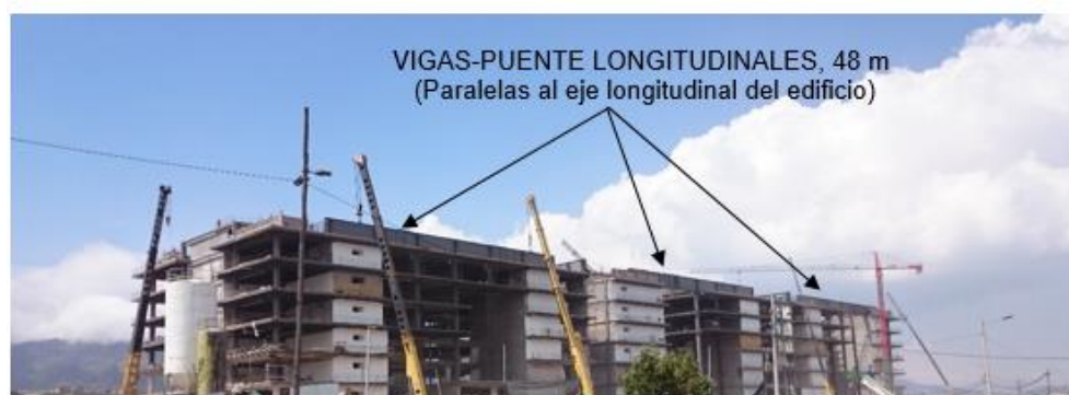
Figura 12 Vigas-puente longitudinales en último piso de Plataforma Social.
