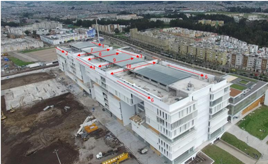
Figura 16b Vista aérea isométrica de las 10 vigas-puente alojadas en último piso de la Plataforma Gubernamental Social durante la etapa de culminación de la estructura.
