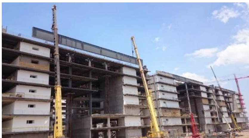
Figura 15b Montaje de vigas-puente de la Plataforma Gubernamental Social etapa final.
