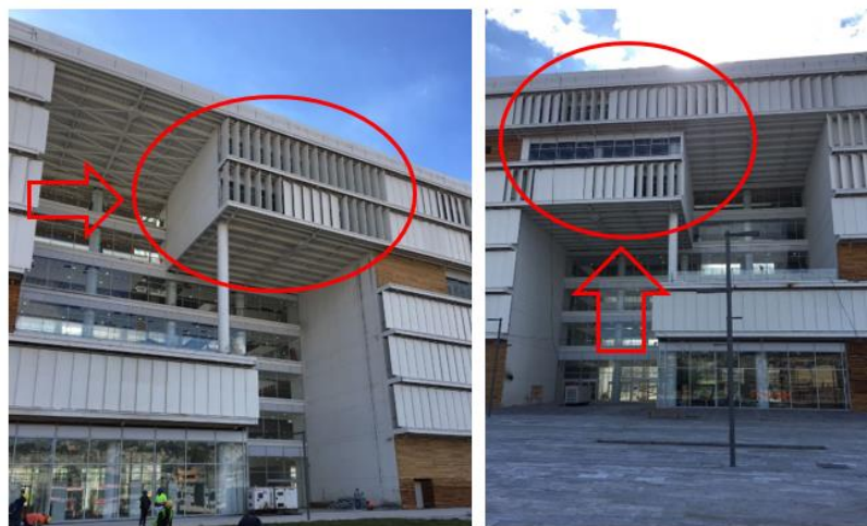
Figura 2 Pisos suspendidos de la Plataforma Social.
