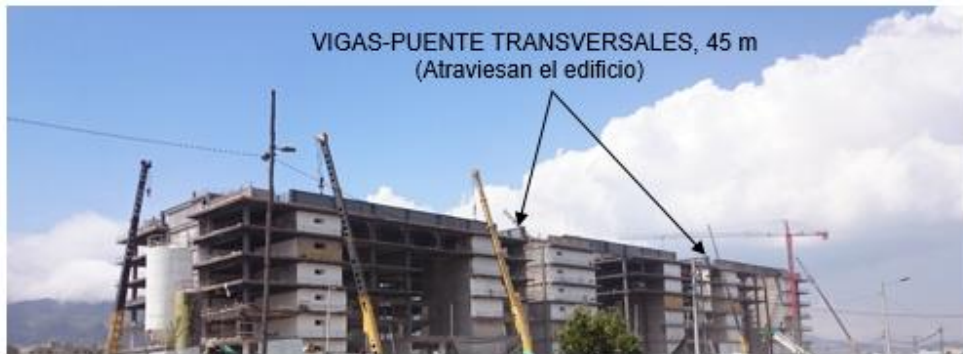
Figura 13 Vigas-puente transversales en último piso de Plataforma Social.
