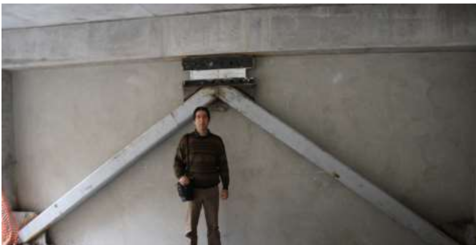
Figura 1 Torre Paradox en Santa Fe, México con Disipadores SLB.
