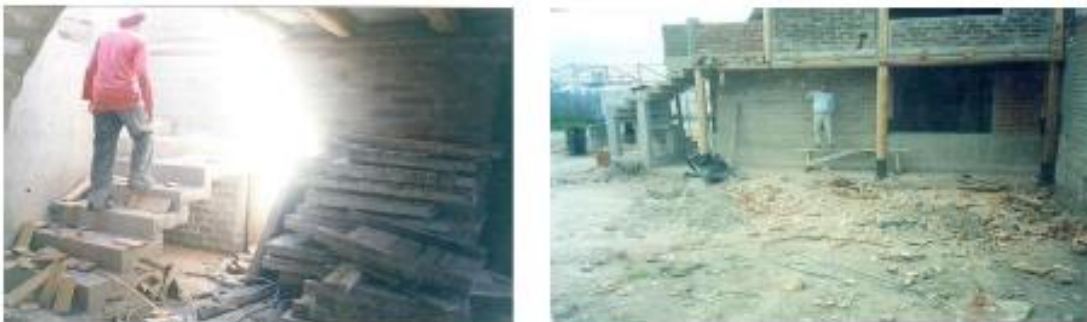
Figura 2 El desperdicio de material es evidente en uno y otro proyecto
