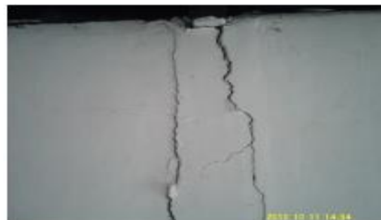
Figura 1. Fallas por falta de mano de obra no calificada en las edificaciones analizadas.
