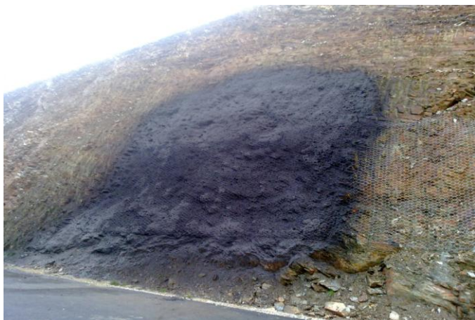
Fotografía 11.- Instalación del Tecnosol
