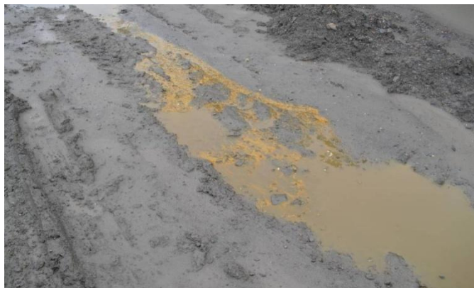
Fotografía 8.- Yellow boys en terraplén
