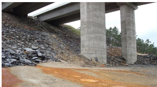
Fotografía 9.- Yellow boys en terraplén
