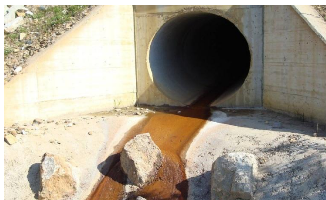
Fotografía 4.- Desembocadura de drenaje transversal
