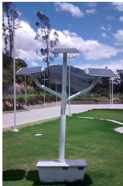
Fig. 6. Proyecto de árbol solar del sistema de carga de celulares y laptops.
