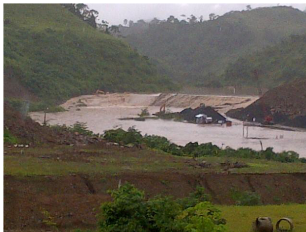
Fig. 1 Desbordamiento sobre la corona de la ataguía
