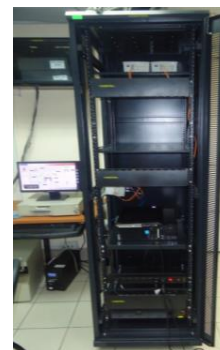
Fig. 6 Rack de comunicaciones concluido
