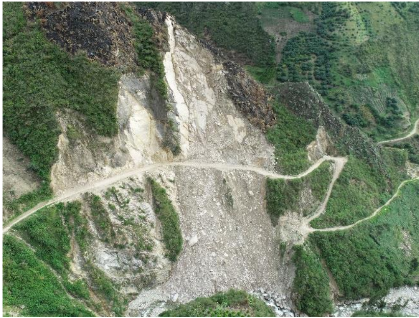
Figura 14. Deslizamiento ubicado al sur del poblado Monte Olivo.
