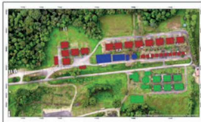
Figura 7: Vivienda fiscal del sector de reconocimiento
