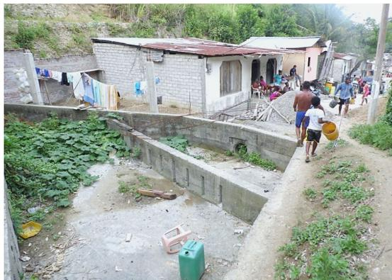
Figura 39: Trampas de lodo en mal estado. Barrio “El Embudo”, (marzo 2017)
