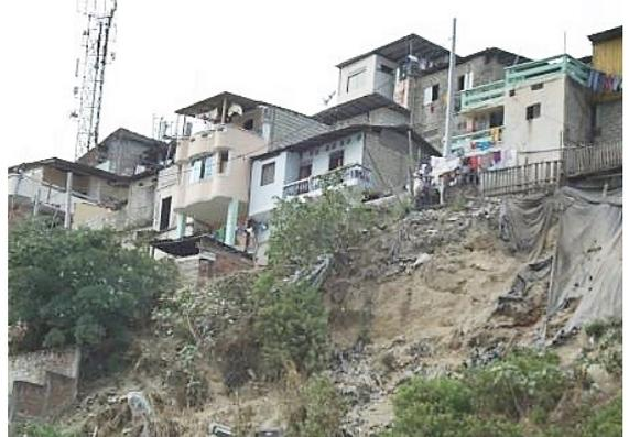
Figura 88: Talud inestable sobre Av. Kennedy
