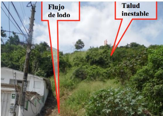
Figura 48: Flujos de lodo al pie de los taludes. Calle Luis Tello - "Las Palmas"
