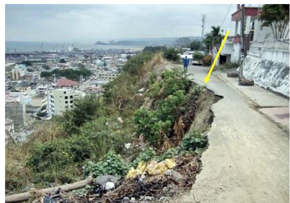
Figura 86: Erosión retrocedente en la corona, (año 2012)
