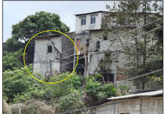
Figura 25: Fracturas por efectos de reptación del suelo, barrio "El Tercer Piso" – Esmeraldas
