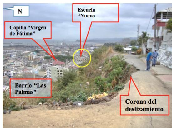
Figura 32: Deslizamiento activo con erosión retrocedente, barrios “Tercer Piso” y “Las Palmas”, año 2012.
