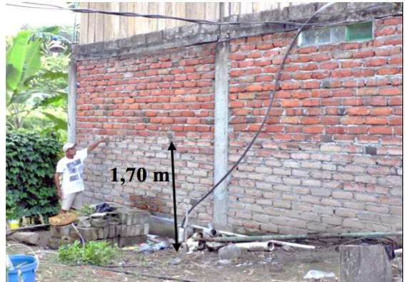
Figura 72: Altura de inundación fluvial en febrero de 2016, en el barrio “La Propicia I”
