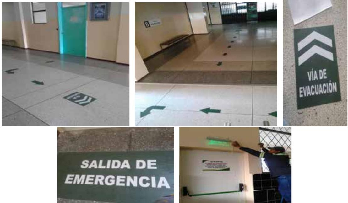
**Figura 31 a-e:** Se implementó señalética de evacuación y salidas de emergencia tanto horizontal y vertical en los bloque A, B, C y D para una adecuada evacuación de la comunidad universitaria.
