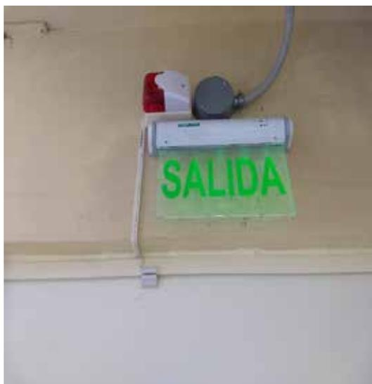
Figura 38: Luces estroboscópicas colocadas en las puertas de emergencia
