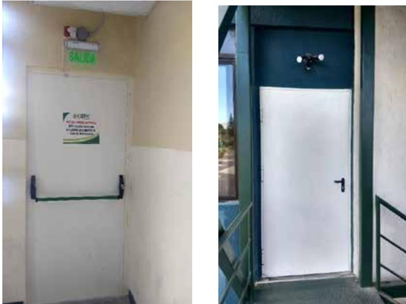
**Figura 35 a y b:** Puertas antifuego con barra antipánico las cuales se encuentran instaladas en las escaleras de emergencia
