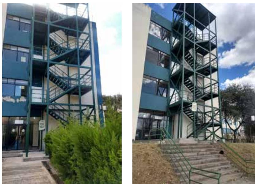
**Figura 34 a y b:** Escaleras de emergencia ubicadas en los bloques C y D
