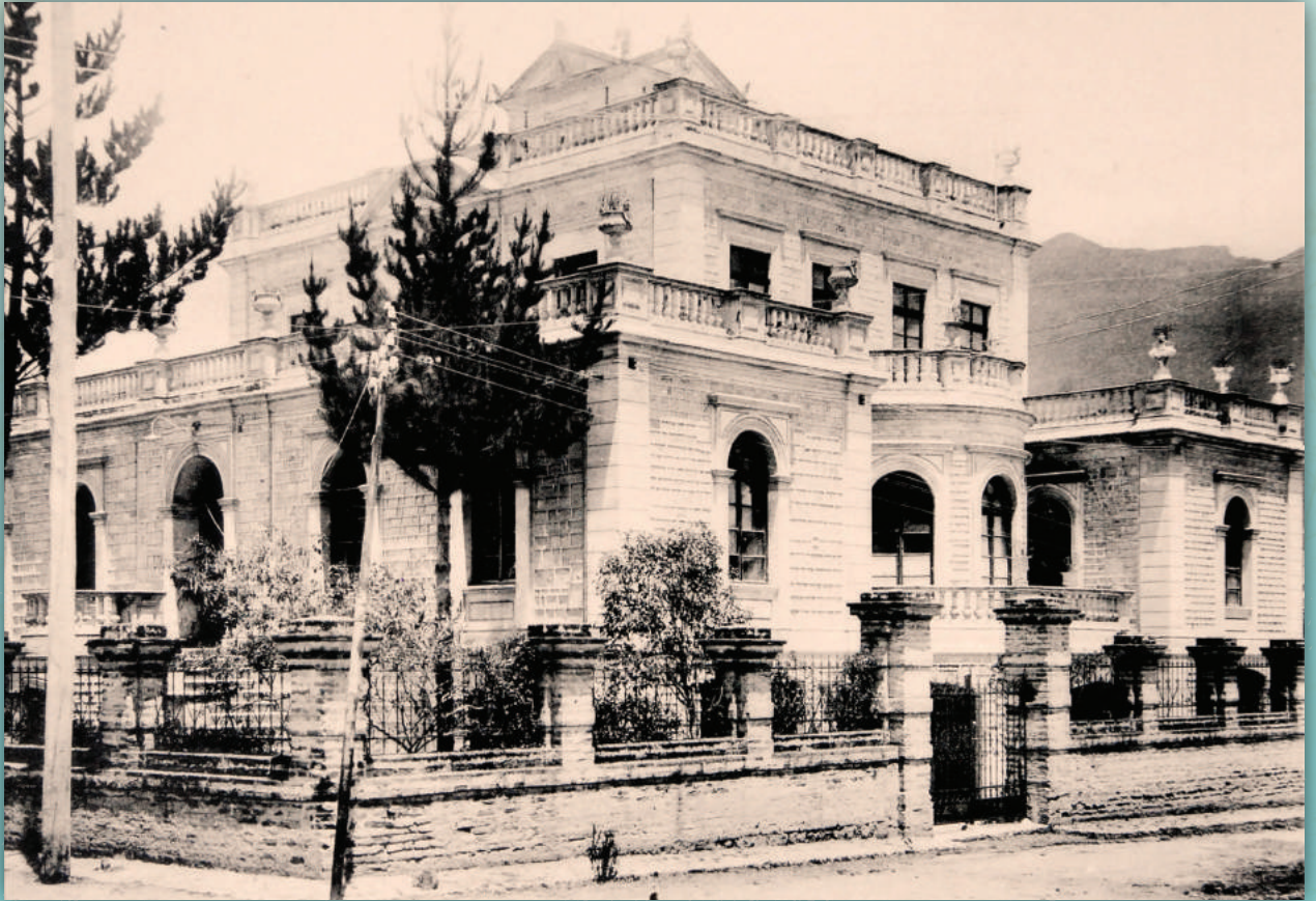
Quinta presidencial asignada a la Escuela de Oficiales de Ingeniería, 1922. Estaba ubicada en la Av. Patria, fue derrocada en 1949 para la construcción de la Embajada de los Estados Unidos en el Ecuador (Foto: Alfonso Ortiz)
