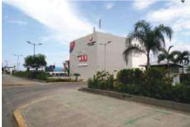
Foto 12: Instalaciones del Centro ECU 911 de Esmeraldas en zona de afectación directa por tsunami.
