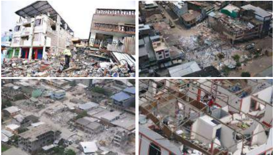
Fig. 2a-d: Varios ejemplos del poder destructivo del terremoto en Manabí. Fuente Associated Press.
