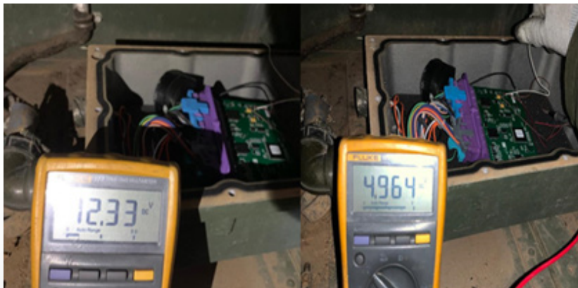
Figura 6: Verificación de funcionamiento tarjeta reparada
