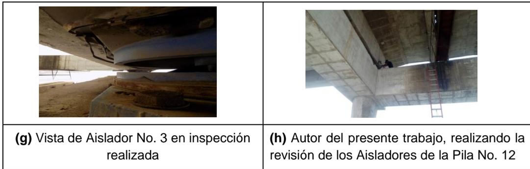
**Figura 5** Fotografías que sintetizan el comportamiento de los Regímenes de Deslizamiento del Aislador TPF
