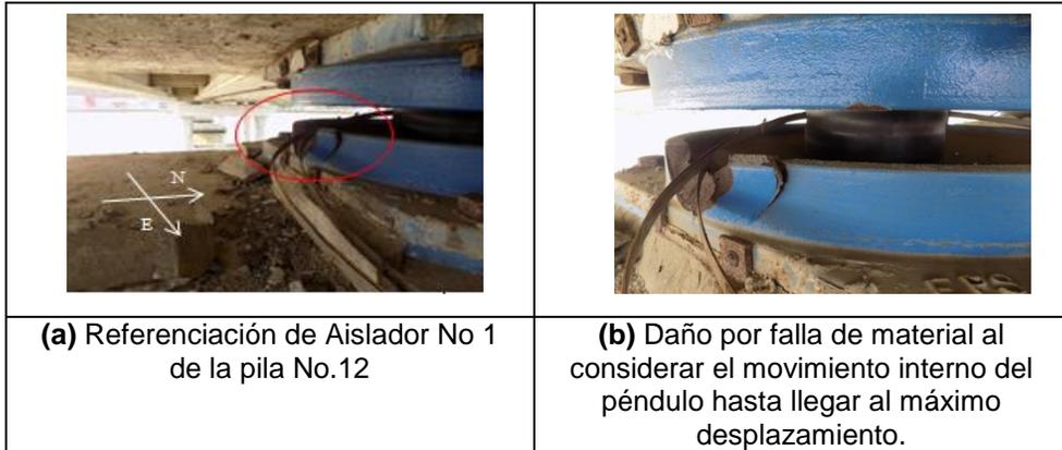
**Figura 11** Evidencia de la dirección del sismo del 16 de Abril de 2016, de acuerdo al daño presentado en el Aislador No. 1
