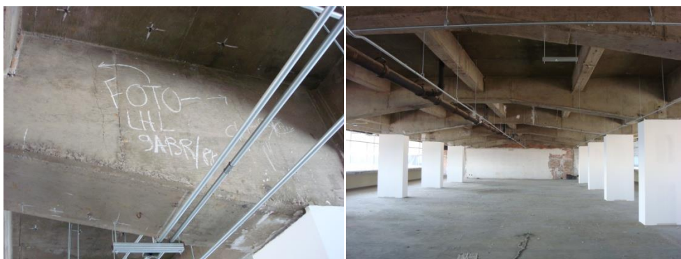
a) Trabe en zona central, nivel 11
