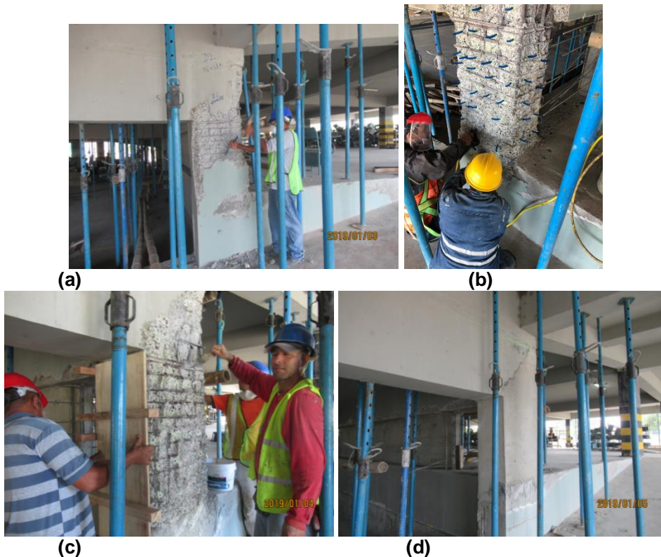
Figura 11 Reparación de columna D2; a) Se quitó el recubrimiento de la parte inferior de la columna; b) Se realizó las inyecciones con resina epóxica; c) Con una brocha se coloca la pega de hormigón viejo a hormigón nuevo, mientras otro operario está probando los encofrados; d) Vista de la columna reforzada en que se colocó Grout.
