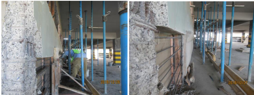
Figura 9 a) Colocación del hormigón mediante un chaflán que se hizo en la parte superior; b) Vista del chaflán una vez que ha sido quitado el encofrado. El chaflán (forma triangular que sobresale) se pica posteriormente.
