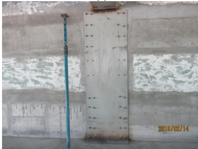
Figura 19 Encamisado con acero A36 de 1 cm, de espesor en columnas de muro de eje D; a) Columna interiores; b) Mayor seguridad con una placa adicional que va en el muro, el mismo que está sujetado con pernos que pasan de lado a lado (son los pernos que aparecen al lado de columna)
