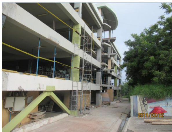
Figura 6 Vista del Pórtico G, y columnas encamisadas con FRP en el primer piso y acero en segundo piso y tercer piso.
