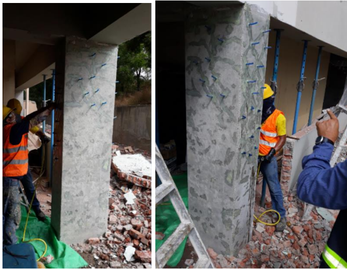
Figura 8 Inyecciones de resina epóxica en columna G5, Nivel 2.97 se empleó 3 Kg
