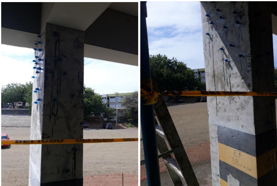
Figura 9 Inyecciones de resina epóxica en columna A2, Nivel 4.59 se empleó 2 Kg
