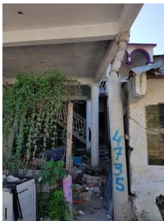
b) Detalle de eje sin muros
