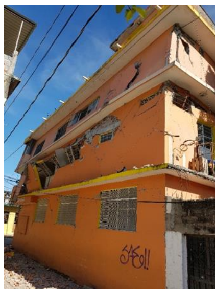
b) Fachada lateral
