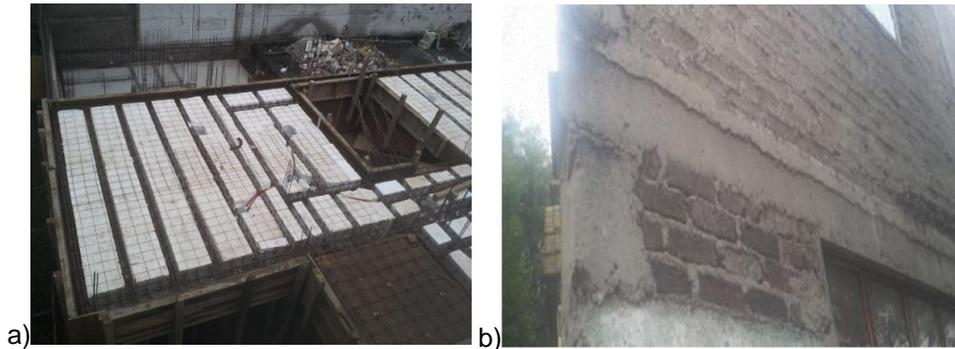
**Figura 6.** Tipos de colado en losas de concreto reforzado con sus vigas de apoyo: a) colado monolítico y b) colado no monolítico.
