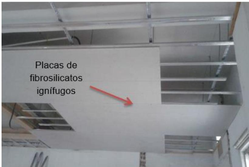
**Figura 6** Cielo raso de placa de fibrosilicato ignífugo
