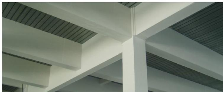
**Figura 3** Aplicación de pintura intumescente (AISLAMIENTO IGNÍFUGO, 2019)
