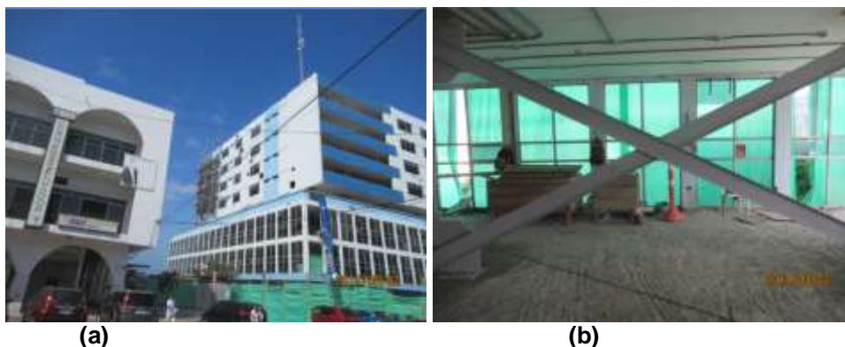
Figura 1 Edificio de hormigón armado que se está reforzando con diagonales de acero en la ciudad de Manta; a) Vista del edificio en el extremo izquierdo se observa los vanos reforzados; b) Diagonal en forma de “X” en uno de los vanos; la diagonal es una IPE-200.
