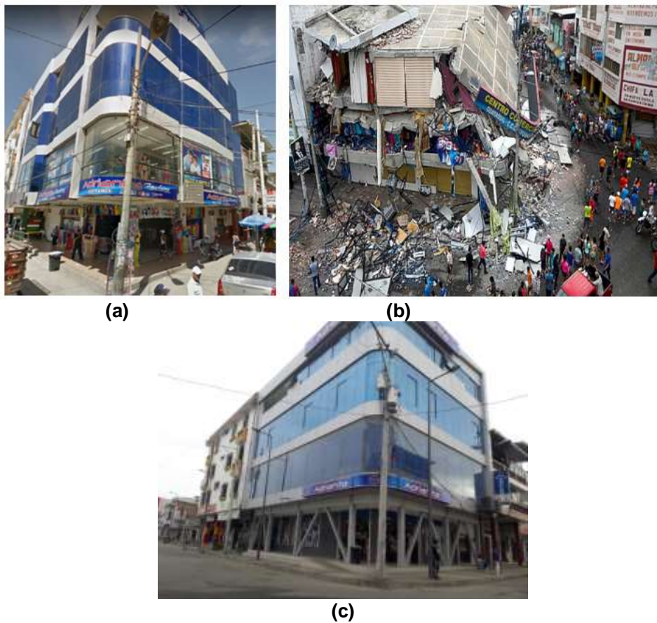
Figura 2 Edificio Adrianita, ubicado en la parroquia Tarqui de Manta; a) Edificio antes del terremoto de 2016; b) Colapso del “edificio abierto” durante el terremoto del 2016; c) Edificio construido después del terremoto.
