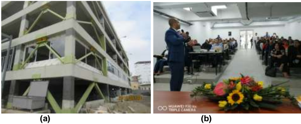
Figura 7 a) Las autoridades de la ULEAM, decidieron que el reforzamiento quede visible; b) Una rampa convertida en Auditorio.
