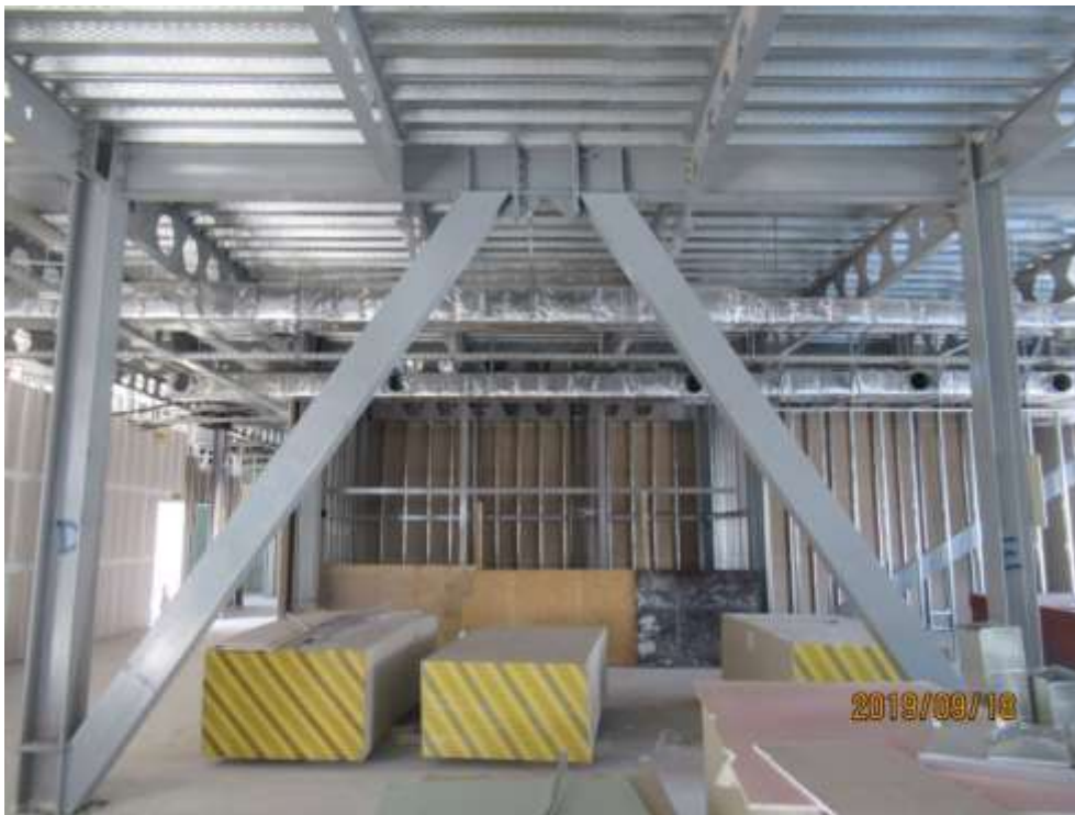
Figura 1 d) Elemento de enlace. Nótese que debajo del enlace se tiene una placa vertical y también tiene pernos.
