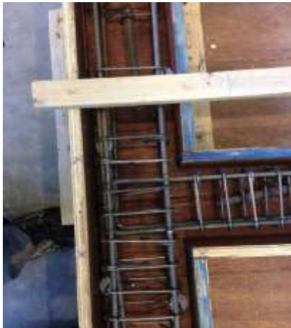
Figura 6 Detalle del nudo viga-columna.
