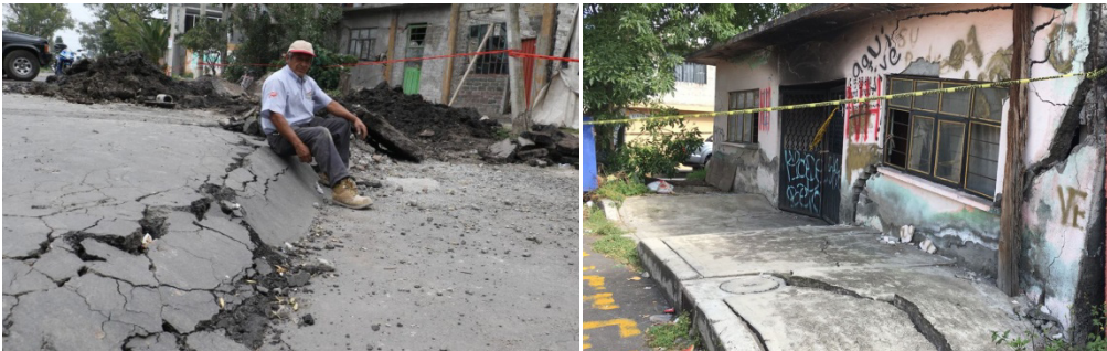
Figura 16 Grietas de tensión en el suelo ocasionados por enormes hundimientos diferenciales súbitos que se presentaron en la colonia del Mar, en la Alcaldía Tláhuac, durante el sismo del 19 de septiembre de 2017 ( M_w=7.1 ). Fotos tomadas de internet
