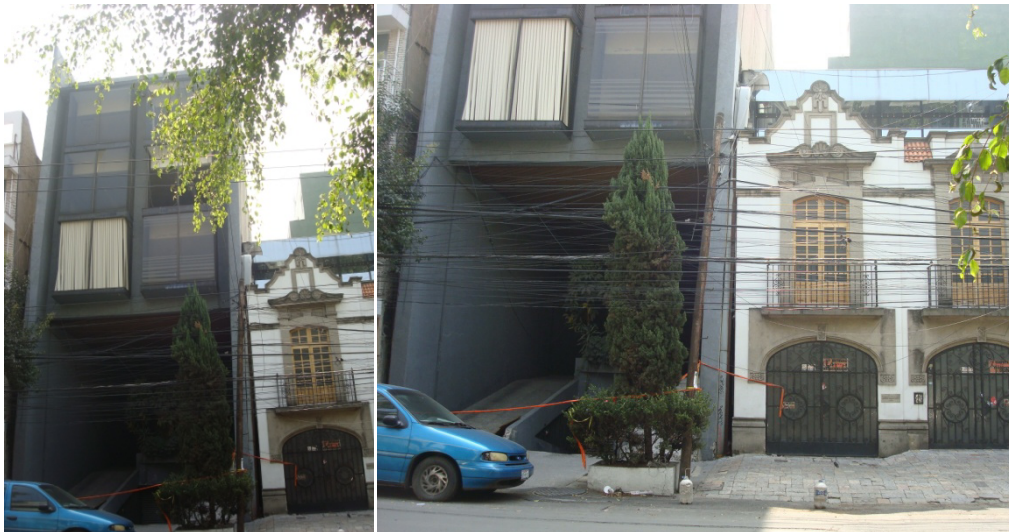
Figura 15 Edificio ubicado en los suelos blandos consolidados de la colonia Roma Norte y que, entre otras cosas, experimentó un enorme desplome durante el sismo del 19 de septiembre de 2017 ( M_w=7.1 ). Además de los problemas del diseño de su cimentación, son evidentes los hundimientos diferenciales a través del tiempo, comparando su nivel con la casa ubicada a su derecha. Fotos tomadas por el autor
