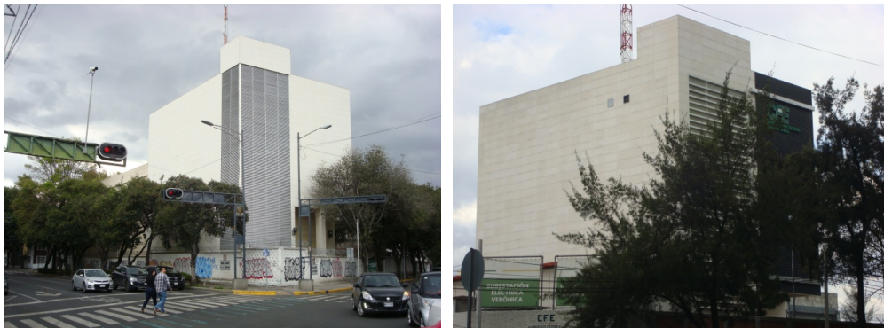
a) Subestación Narvarte
