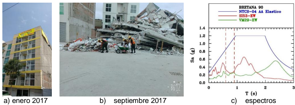
Figura 29 Colapso del edificio de departamentos en Breaña 90 durante el sismo del 19 de septiembre de 2017. El edificio se terminó de construir a finales de 2016. Se presentan los espectros de diseño elástico ( Q=1 ) del Apéndice A de las NTCS-04 para el sitio Breaña 90 ( T_s=1.654 s), ubicado en la colonia Zacahuitzco y su comparación con los espectros de respuesta elásticos para \zeta=5\% más las estaciones más cercanas SI53 y VM29. Las estaciones son operadas por el CIRES.
