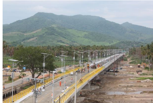
Figura 11 Reconstrucción puente Coyuca I (SCT, 2014)
