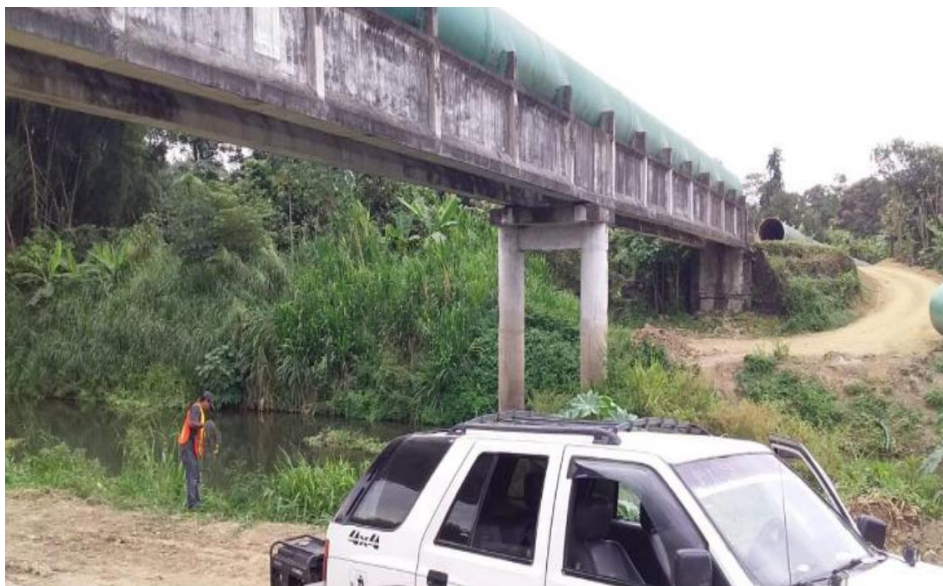
Figura 10b Vista lateral del Puente 3
