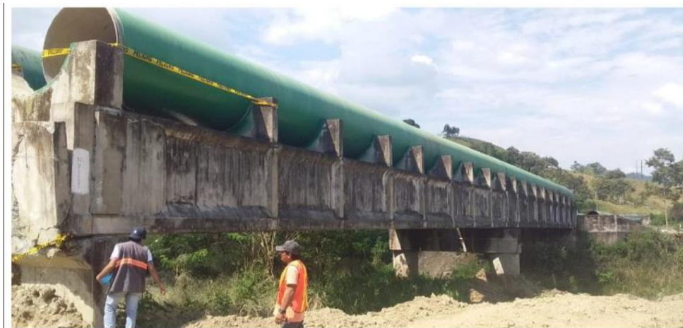
Figura 8b Vista lateral del Puente 2
