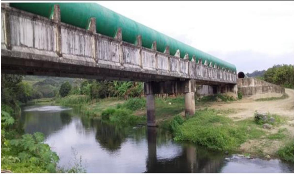
Figura 7b Vista lateral del Puente 1
