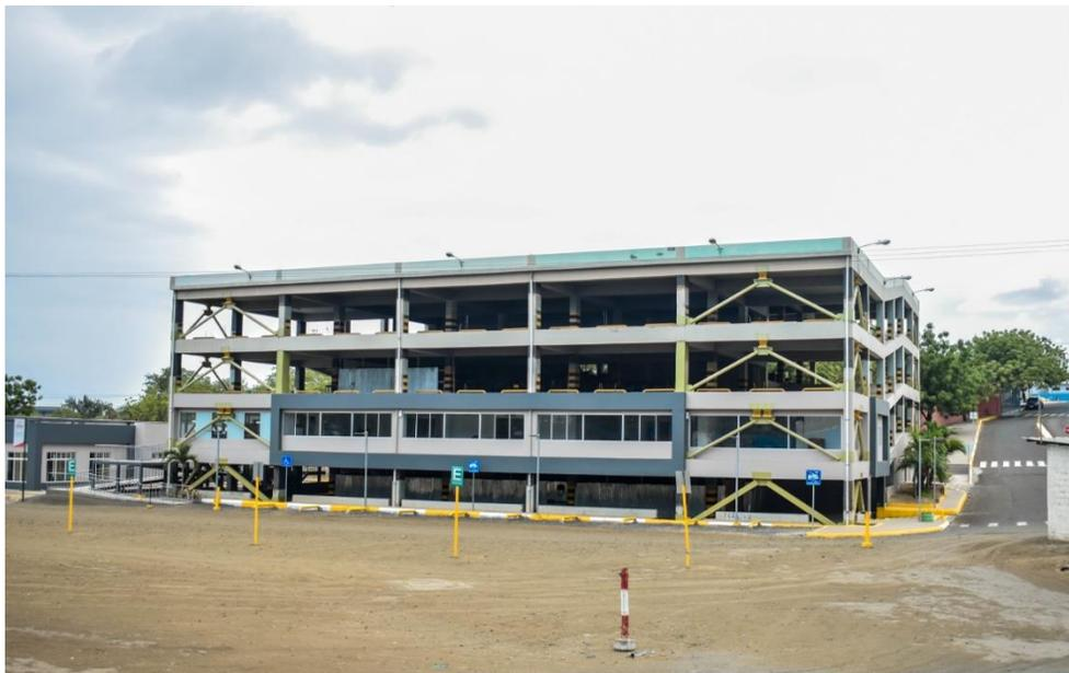
**Figura 3** Reforzamiento sísmico del parqueadero de la Universidad Laica Eloy Alfaro de Manabí, ULEAM. En la parte superior se presenta una vista de las diagonales en forma de V invertida colocadas en la planta baja; en la parte inferior panorámica de la estructura reforzada con disipadores de energía sobre diagonales, del segundo al cuarto piso.
