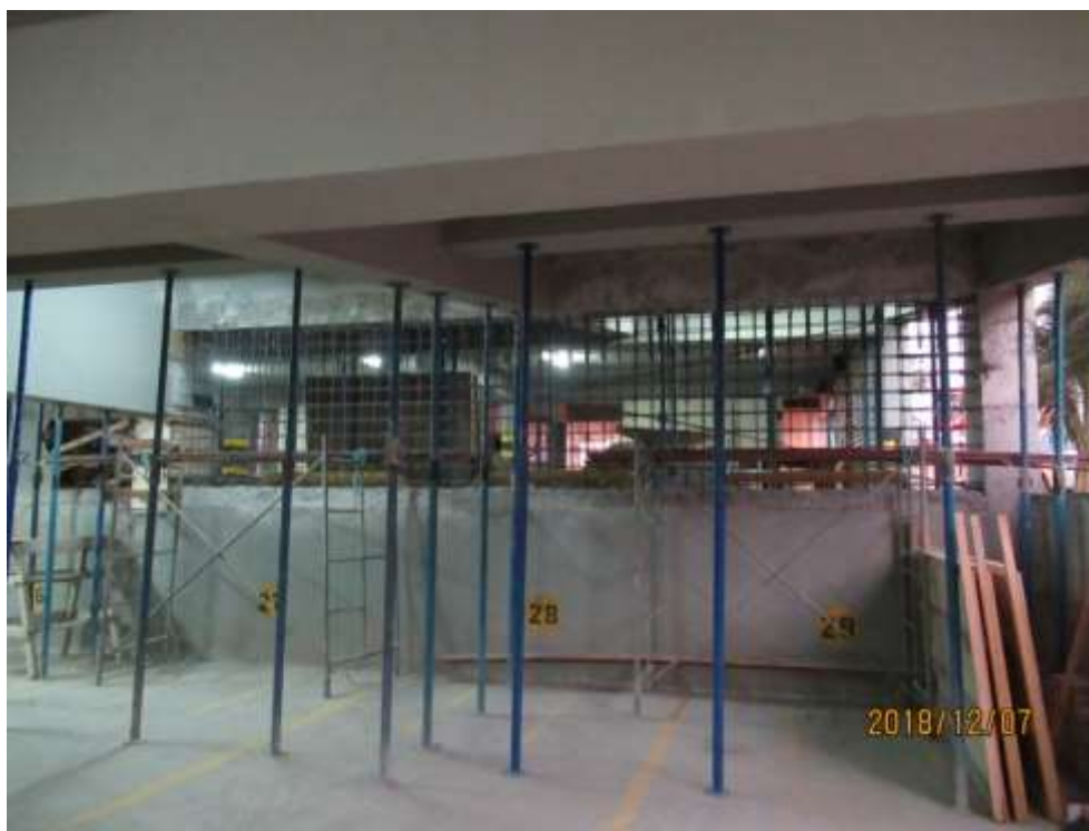
Figura 23 Derrocamiento de mampostería y construcción de muro de hormigón armado. Fuente: Aguiar y Del Castillo (2019)
