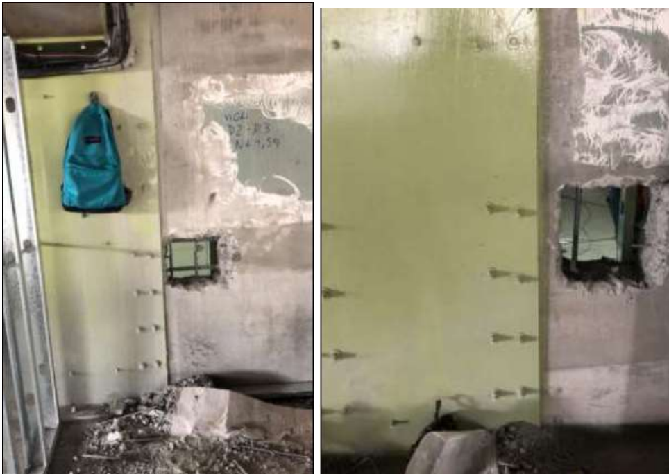
Figura 28 Aberturas en muros del Pórtico D, realizadas en etapa de terminados.
