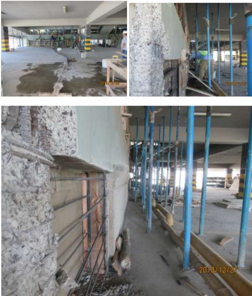
Figura 24 Colocación del hormigón en uno de los muros, se aprecia que se fundió hasta un metro antes de la columna y en la fotografía inferior se ve el chafán que luego se eliminó. Fuente: Aguiar y Del Castillo (2019).
