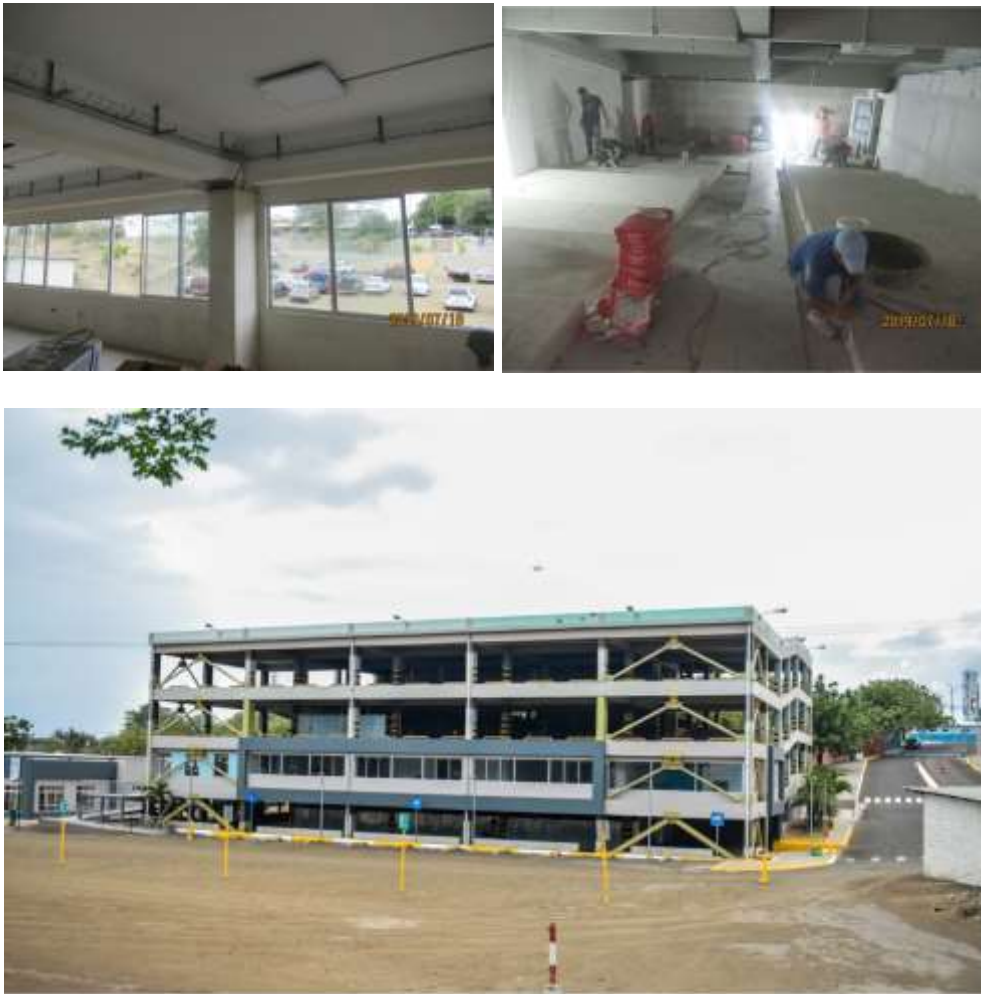
Figura 47 Cambio de función de parqueadero a edificio administrativo; en la fotografía superior izquierda se ven las instalaciones al lado de las vigas; a la derecha las rampas pasan a ser auditorios y abajo una panorámica donde está terminado el segundo piso.
