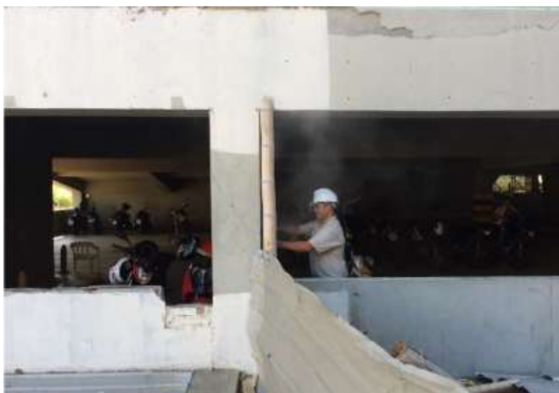
Figura 19 Efecto de columna corta en columna G5 de planta baja. Fuente: Del Castillo D., (2018)
