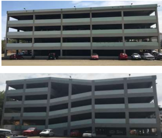
Figura 1 Ex parqueadero de la ULEAM; a) Fachada Frontal; b) Fachada Lateral Izquierda.
