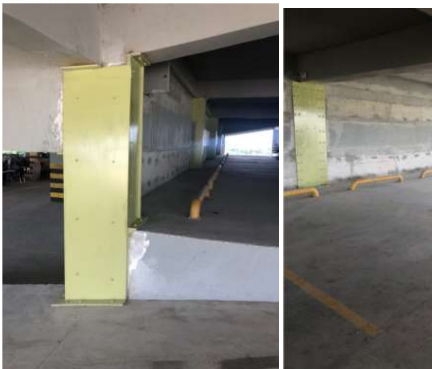
Figura 26 Reforzamiento de las columnas del eje D. Primero se le repara (foto superior) y después se reforzó con encamisado de acero. Fuente: Aguiar y Del Castillo (2019).
