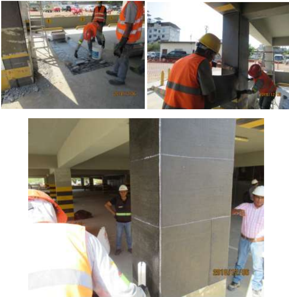
Figura 20 Confinamiento de una columna con fibra de carbono; en la parte superior izquierda se ve la colocación del imprimante; a la derecha se observa la colocación con un traslape vertical de 10 cm; en la fotografía inferior se ve la colocación de imprimante, para que la fibra quede encapsulada.
