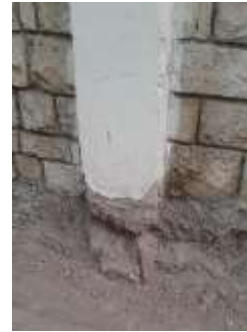
Figura 9. Degradación del hormigón y la armadura en pie de columna
