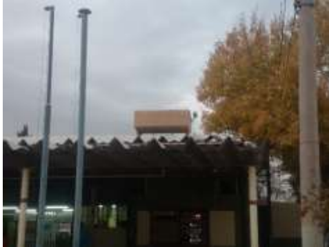
Figura 5 y 6. Gran peso del tanque para reserva de agua con probable caída por un sismo sobre una cubierta liviana que no lo soportaría.
