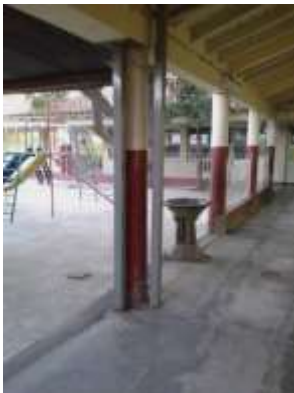
Figura 10. Refuerzo estructural en columna.
