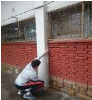
Figura 7. Verificando probabilidad de caso de columna corta.
