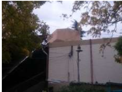
Figura 5 y 6. Gran peso del tanque para reserva de agua con probable caída por un sismo sobre una cubierta liviana que no lo soportaría.
