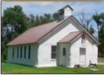
Figura 4. Casa con fardos de paja en el Estado de Nebraska, construida en 1904
