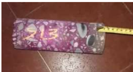
Figura 5. Patologías en el Hormigón.
