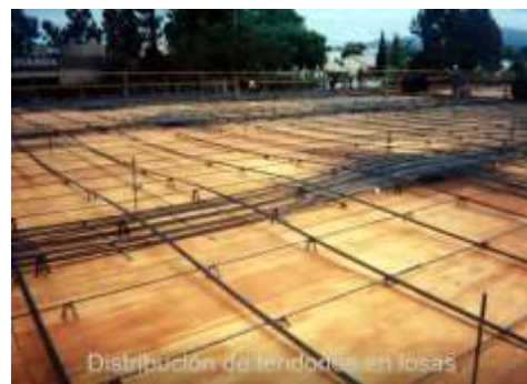
Figura 6. Distribución de tendones tipo banda y distribuidos
