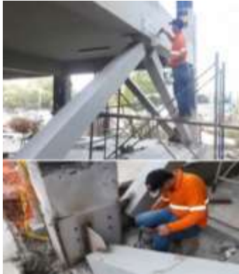
Figura 3. Colocación de diagonales concéntricas para el reforzamiento estructural en el parqueadero de la ULEAM en el primer piso.
