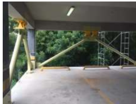
Figura 3 y 4. Aisladores sísmicos utilizados en reforzamiento de Produbanco y la ULEAM respectivamente
