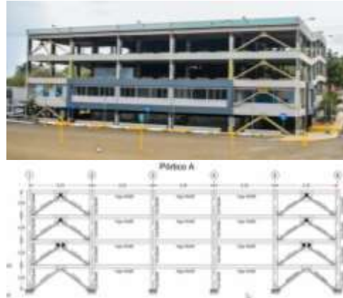
Figura 4. Reforzamiento estructural con diagonales concéntricas y disipadores de energía en el parqueadero de la ULEAM.
