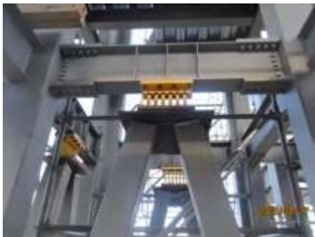
Figura 3 y 4. Aisladores sísmicos utilizados en reforzamiento de Produbanco y la ULEAM respectivamente
