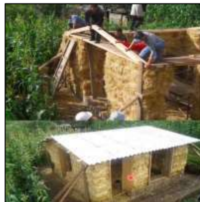
Figura 6. Construcción de una vivienda con fardos paja, tipo Nebraska.
