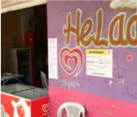
Figura 2. Estructura evaluada con mala gestión de evacuación. Manta.
