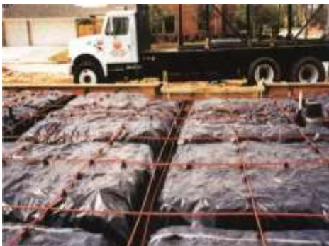
Figura 5. Postensado en losa plana tipo Waffle.
