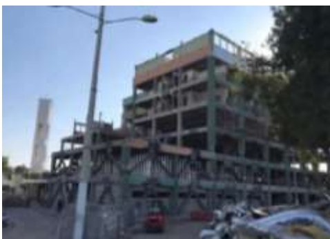
Figura 5 y 6. Reforzamiento Hospital Rodriguez Zambrano y disipadores sísmicos TADAS, al inicio del reforzamiento
