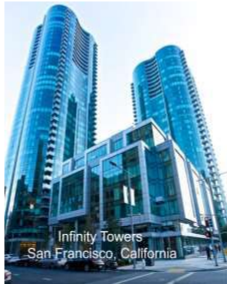
Figura 4. Edificio Postensado en zonas de carga sísmica
