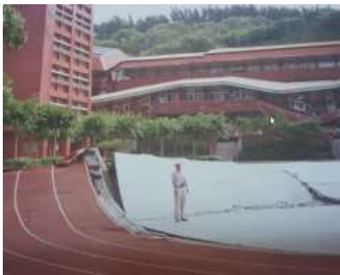
Figura 9. Estructura en Zona de falla
