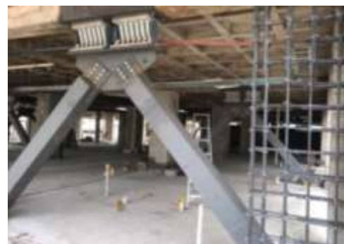
Figura 5 y 6. Reforzamiento Hospital Rodriguez Zambrano y disipadores sísmicos TADAS, al inicio del reforzamiento
