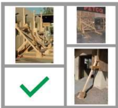
Figura 4. Forma correcta de apuntalar estructuras con daño.
