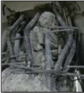
Figura 1. Aplastamiento del borde inferior y pandeo longitudinal en muro de hormigón después del terremoto de Chile del 2010.
