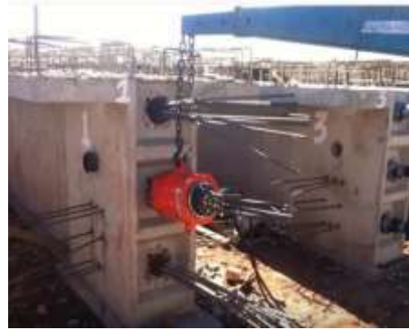
Figura 2. Cable multitoron tensado con gata.
