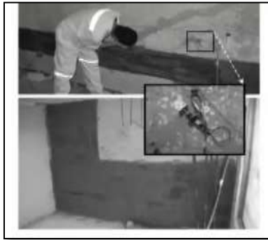
Figura 2. Reparaciones de daños leves con inyección epóxica de grietas.
