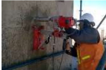
Figura 3. Extracción de Testigos.
