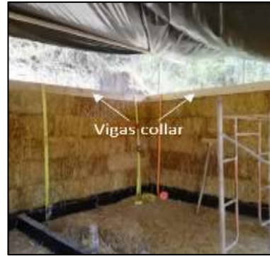
Figura 4. Vigas collar para la compresión de fardos de faja.
