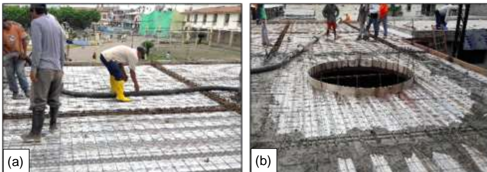
Figura 16. (a) y (b) Fundición por etapas en losas Steel Deck.
