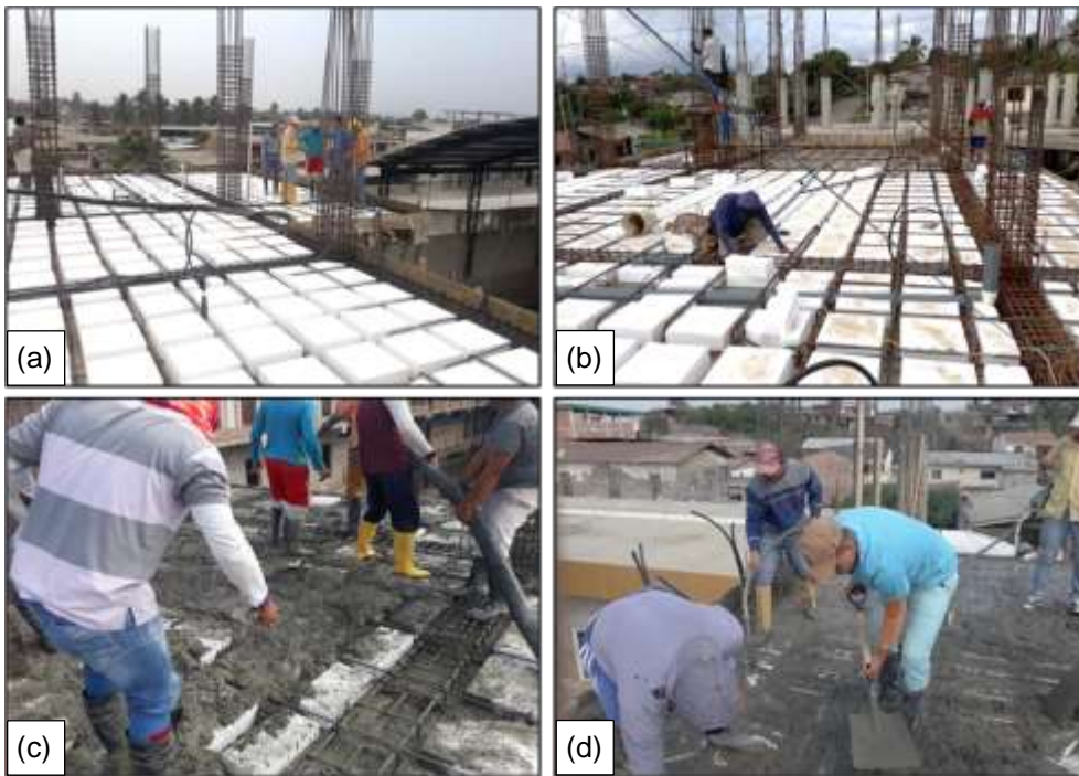
Figura 11. (a), (b), (c) y (d) Anclaje de los bloques de poliestireno expandido durante el vaciado del hormigón.
