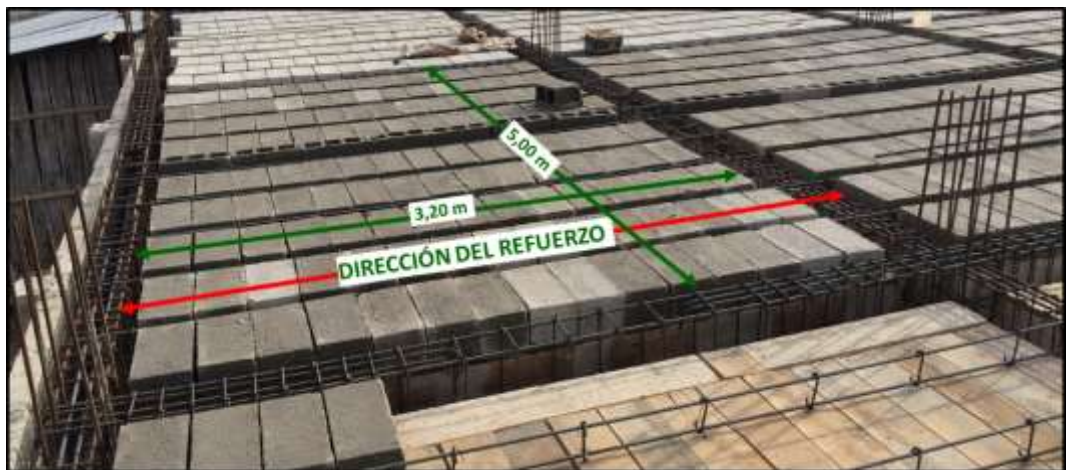
Figura 1. Losa gobernada por esfuerzos de flexión en ambas direcciones, pero reforzada en una sola dirección.
