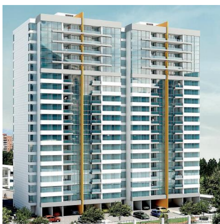
a) Piso suave o débil en primer nivel http://imcyc.com/revistacvt/pdf/enero_2017/ene17.pdf
