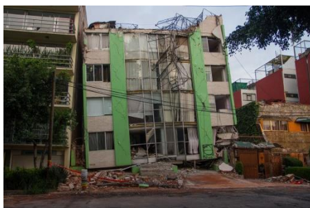
a) Edificio Rebsamen 241
