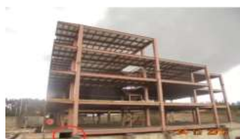
Figura 4. Camino para futuras revisiones de los aisladores
