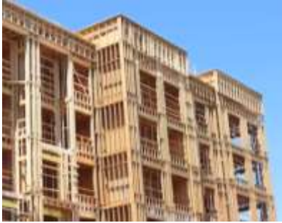
Figura 1. Construcción con entramado ligero de madera (ELM).
