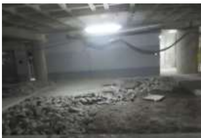
Figura 5. Demolición de contrapisos expandido
