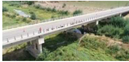
Figura 2: Puente Águila Norte
