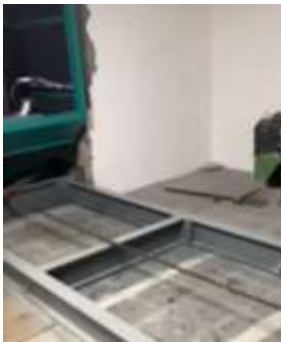
Figura 3. Colocación del generador
