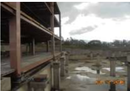
Figura 5. Aisladores colocados en primer piso
