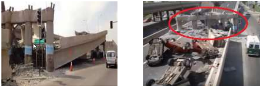
Figura 4 – 5. Columnas sin daño después de un sismo en Chile
