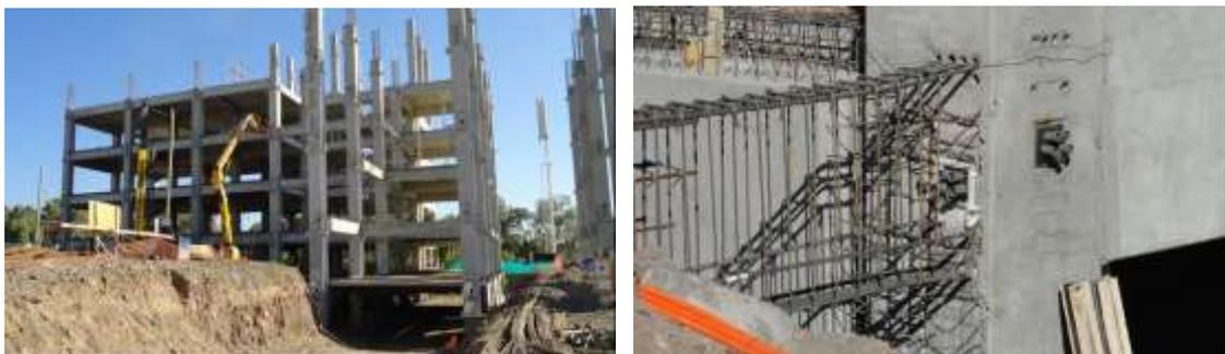
Figura 5. Sistema PRESSS utilizado en la construcción del edificio de 8 niveles del Polo Judicial de la Provincia de Mendoza. Abril de 2019.
