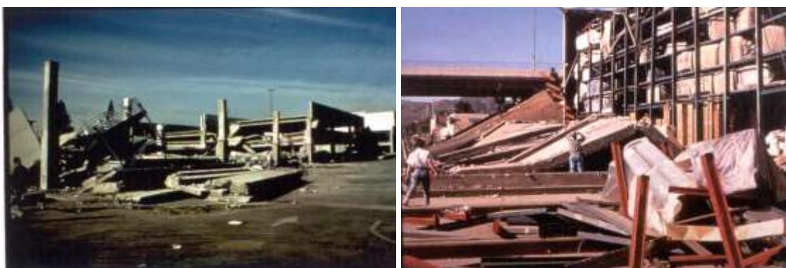
**Figura 1.** Colapsos parciales y totales de construcciones premoldeadas de hormigón armado luego del terremoto de Northridge, 2004
