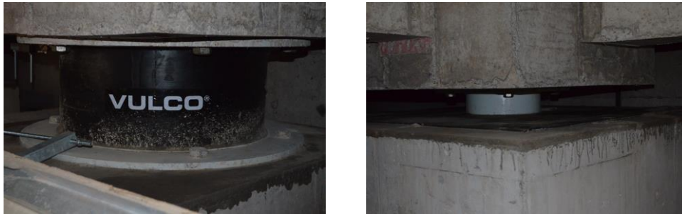
a) Figura 5. Aisladores sísmicos utilizados: a) aislador elastomérico; b) deslizador plano.
