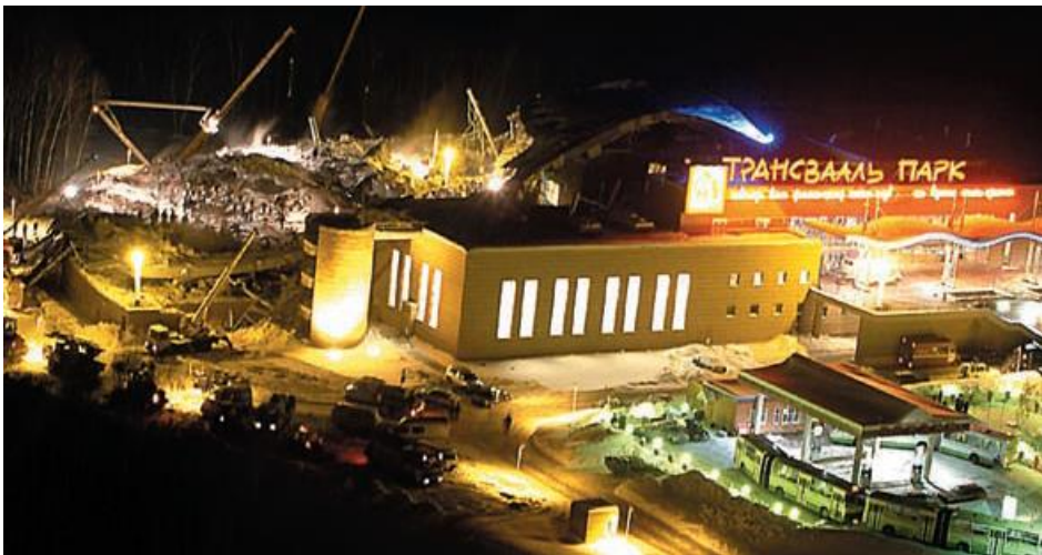
Fig. 8 Parque de agua después del colapso
