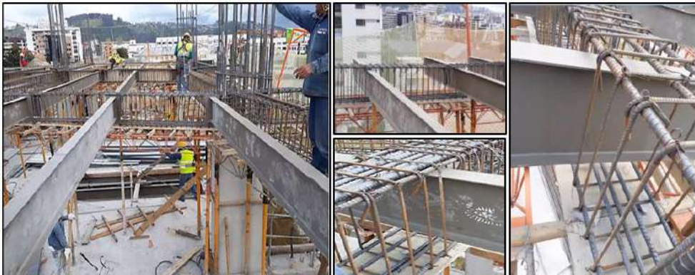
Figura 1. Ejemplos de nudos híbridos en los que la viga pasante de acero invade totalmente la viga de HA
