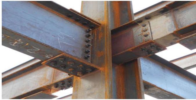
Figura 5. Conexión trabe-columna con cubreplacas atornilladas. Inconveniente para la práctica profesional mexicana. Imagen cortesía: Dr. Michael D. Engelhardt.
