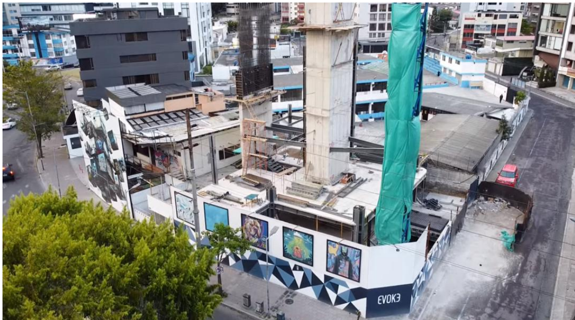
Figura 1. Estructura con un núcleo de hormigón abierto y un muro de hormigón de gran dimensión, rodeados de columnas cruciformes y vigas de acero.
