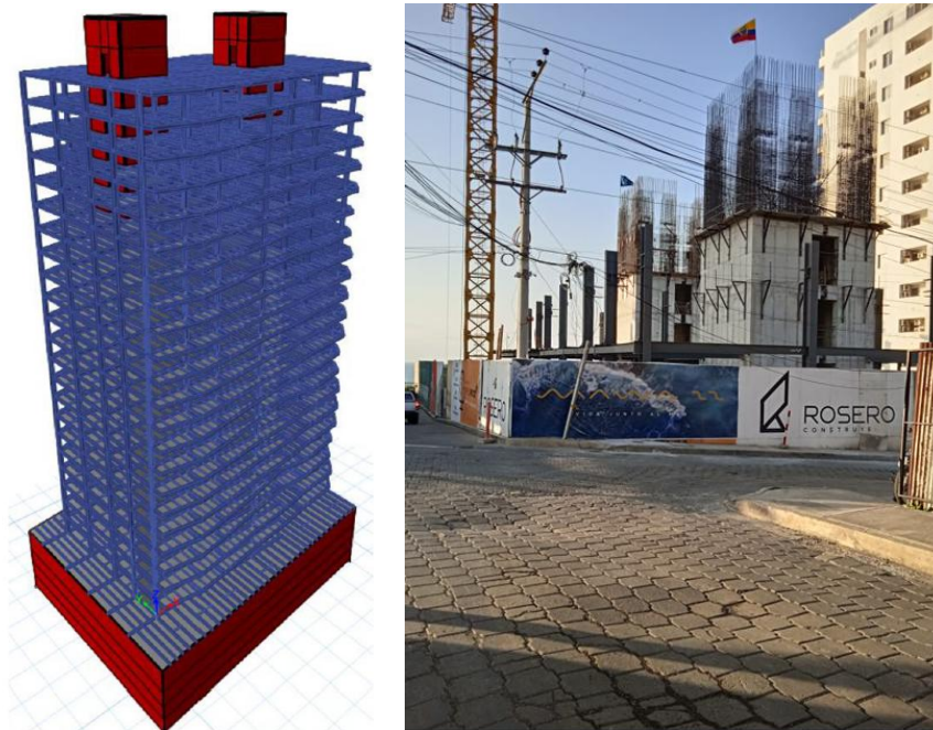
Figura 4. A la izquierda una vista en 3D de estructura de Mawa y a la derecha se aprecian los dos núcleos con los pasillos en cuyas vigas se instalaron SLB.
