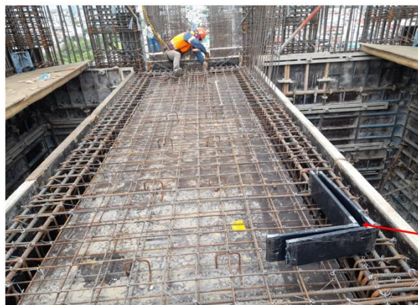
Figura 20. Armado de losa de pasillo de piso 15, a la izquierda sitio donde van los ascensores y a la derecha lugar de la grada al fondo los muros, vigas de acople y sitio de dissipador.
