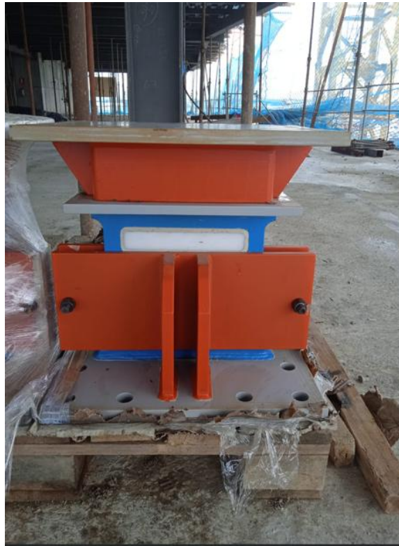
Figura 6. Disipador de energía SLB de cuarta generación como llega al Proyecto.
