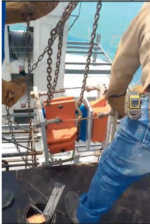
Figura 16. Con la ayuda de un tecla, se ubica el SLB en su sitio.
