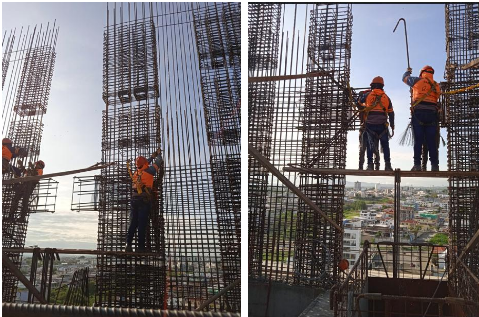
Figura 9. En Mawa el SLB se coloca entre dos vigas cortas, las mismas que se observan en la fotografía de la izquierda; en la fotografía de la derecha ya se ha colocado la armadura diagonal.
