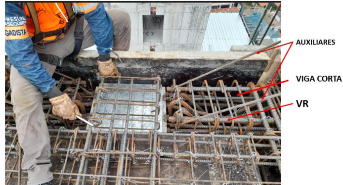
Figura 19. Armadura de la losa del pasillo entre Ascensores y Gradadas.
