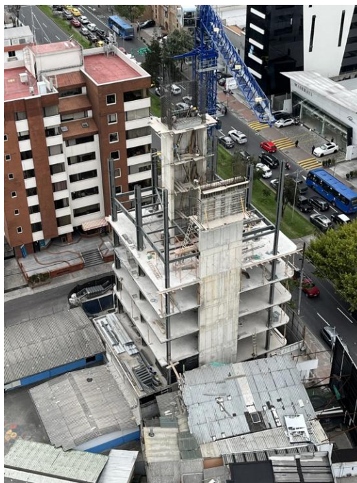
Figura 2. Vista de edificio Evok3 de Sur a Norte se aprecia que el núcleo central es una “C” no hay el problema de viga corta.
