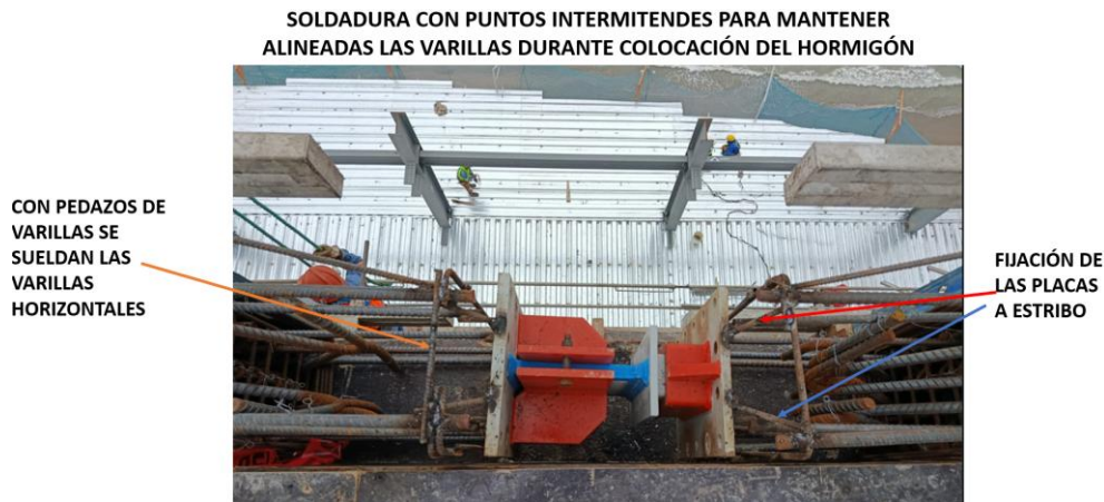
Figura 17 Puntos de suelda y varillas auxiliares para garantizar que no se mueva el disipador durante la colocación del hormigón en las vigas de acople.
