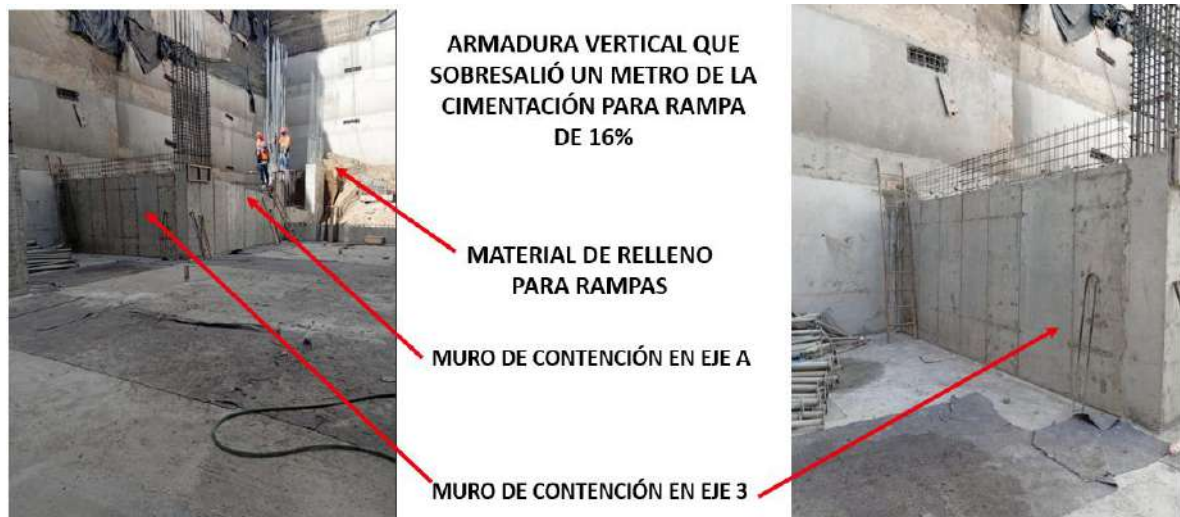
Figura 27 Muros de contención para rampa del 16%
