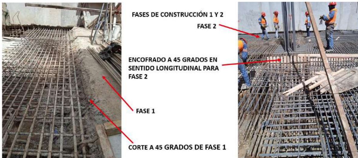
Figura 20 A la izquierda la junta de construcción de la primera fase; a la derecha la junta de construcción en sentido longitudinal antes de fundir la fase dos.
