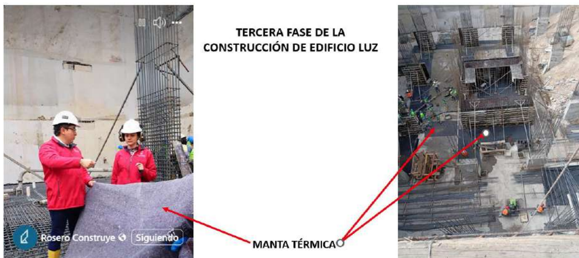
Figura 32 Manta térmica utilizada para el curado del hormigón.
