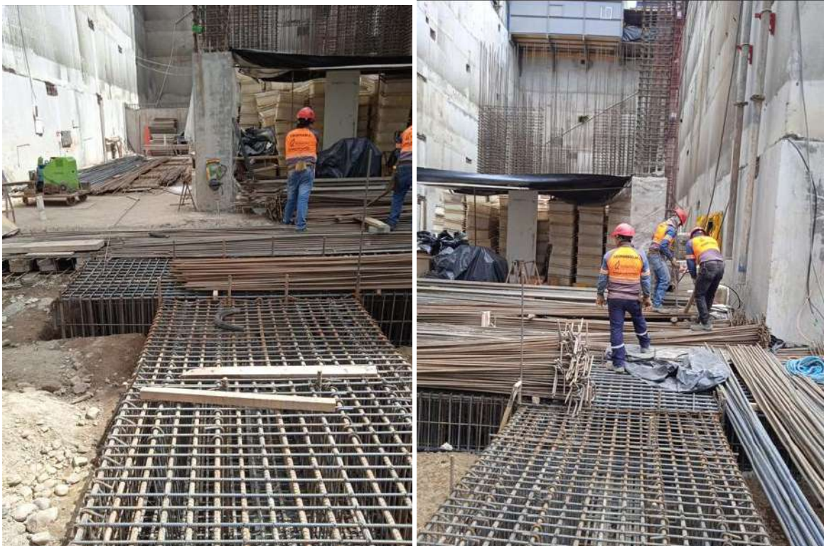
Figura 17 Viga de Cimentación del Eje 1, a la izquierda y del Eje 2, a la derecha.
