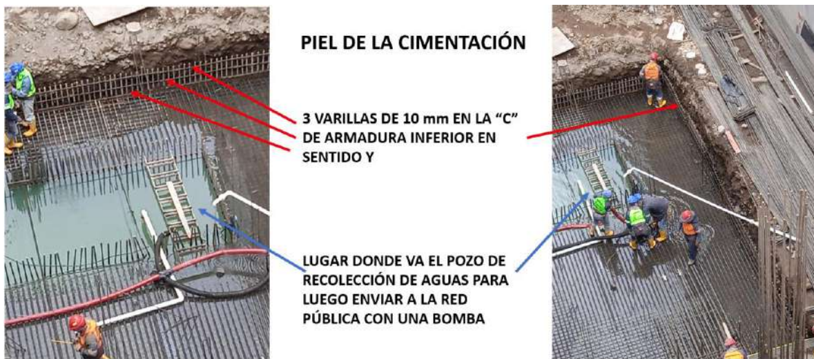
Figura 10 Armadura de piel de malla de cimentación inferior y ubicación del Pozo de aguas.
