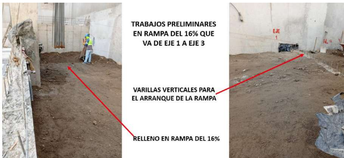
Figura 30 Relleno compactado y armadura de arranque para la rampa del 16 % en el subsuelo S5.
