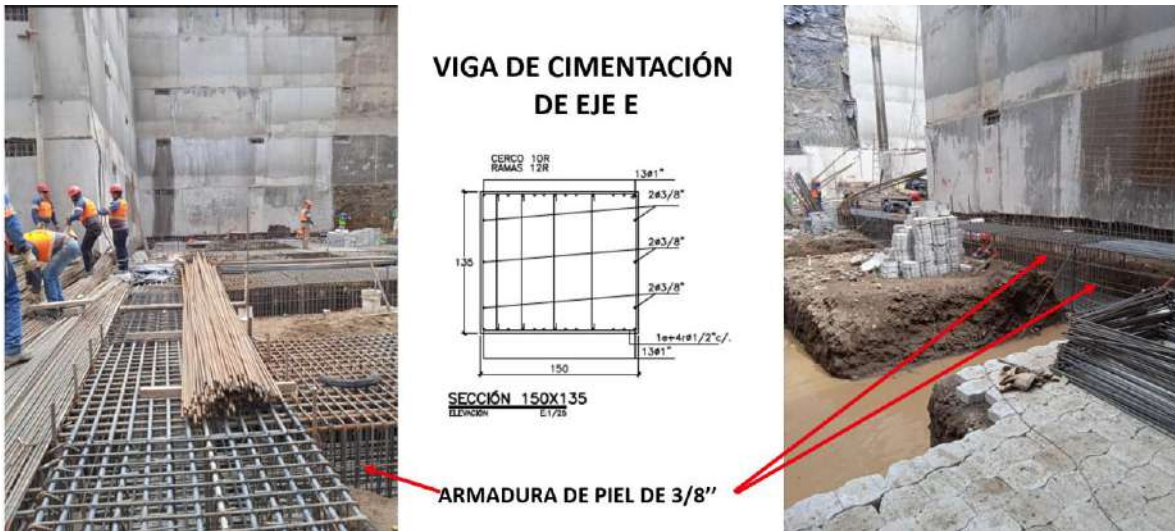
Figura 15 Viga de cimentación de eje E.
