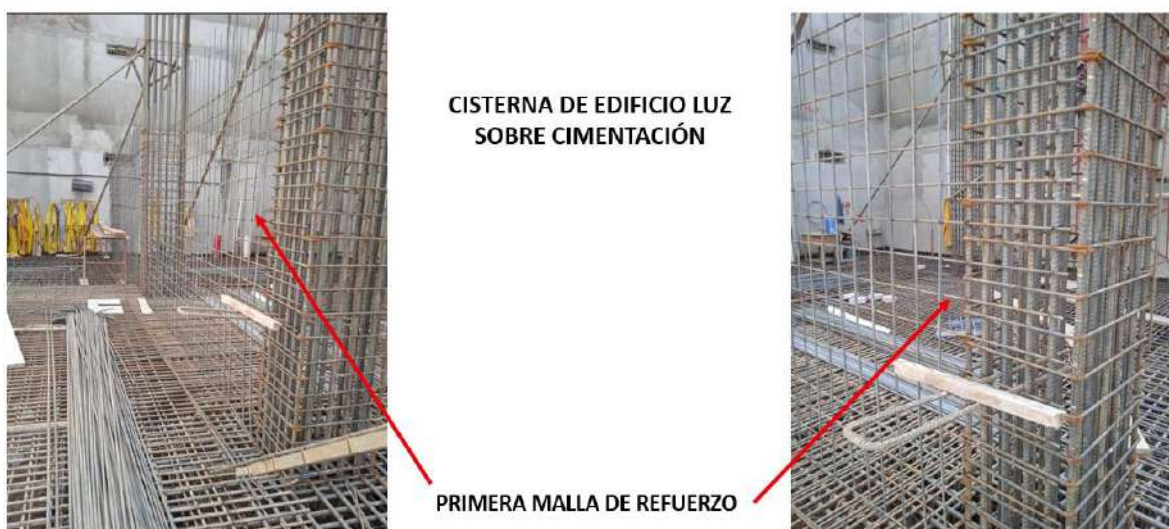
Figura 25 Primera Malla en muro del eje "I" de cisterna de edificio Luz
