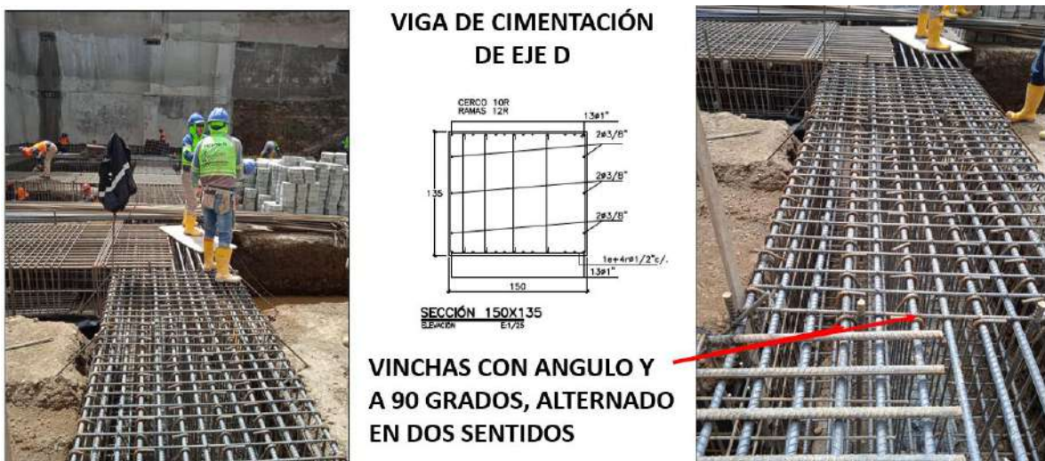
Figura 16 Viga de cimentación de eje D.
