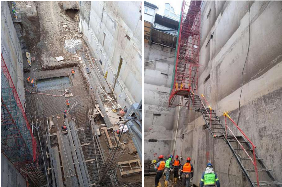
Figura 4 Primera fase de la construcción en ala de “L” y escalera provisional.
