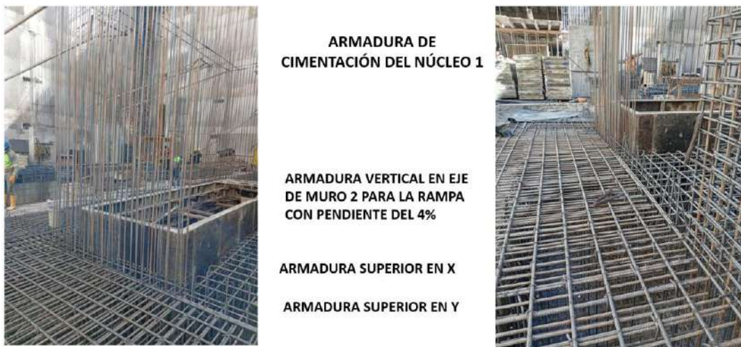
Figura 13 Armadura de la cimentación del Núcleo 1 de muros estructurales.
