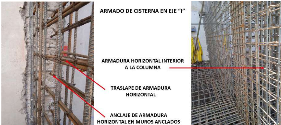
Figura 26 Anclaje de armadura horizontal y mallas de muro en eje "I"
