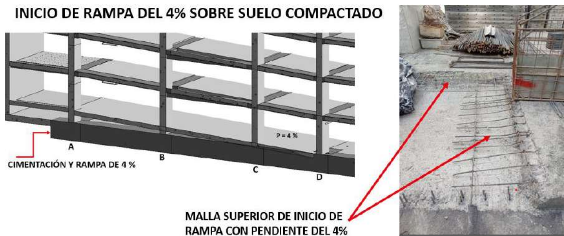
Figura 31 Rampa del 4% y cimentación fundida en fase 2.
