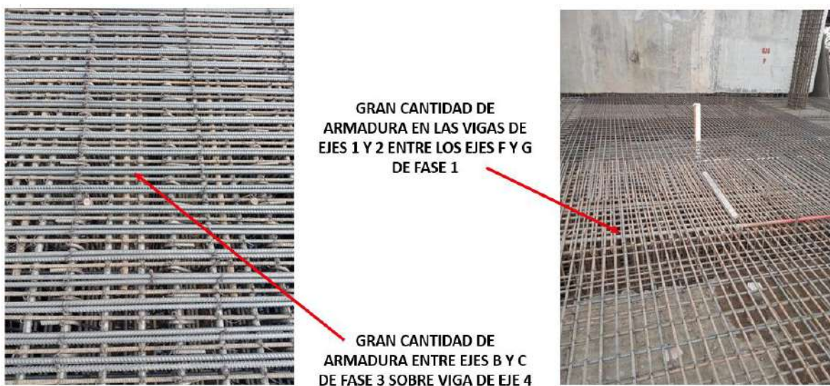
Figura 22 Concentración de armadura sobre las vigas de los ejes 4, a la izquierda y ejes 1 y 2 a la derecha.
