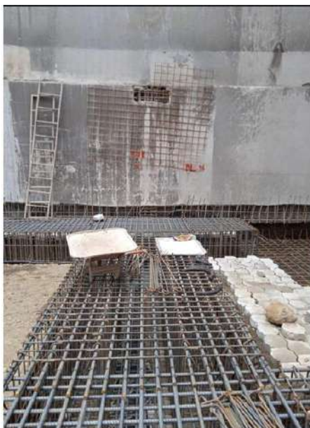
Figura 19 Vigas de cimentación de los ejes 3 y 4.
