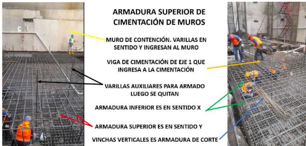
Figura 12 Mallas superior e inferior de cimentación de muros estructurales
