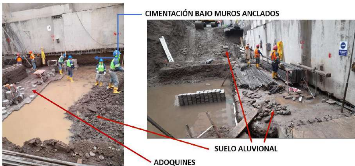
Figura 34 Suelo aluvial, a partir de los 15 m, de profundidad en edificio Luz.
