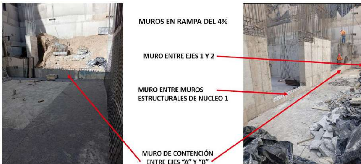
Figura 28 Muro de contención para rampa del 4%
