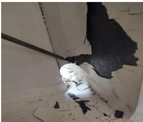
Figura 7. Desprendimiento de pintura y fractura del agujero de acceso para soldar al final de la prueba experimental. Imagen propia.
