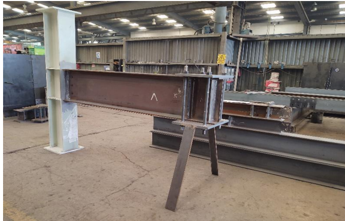
Figura 19. Fabricación de especímenes trabe-columna en taller certificado BAYSA. Imagen propia.
