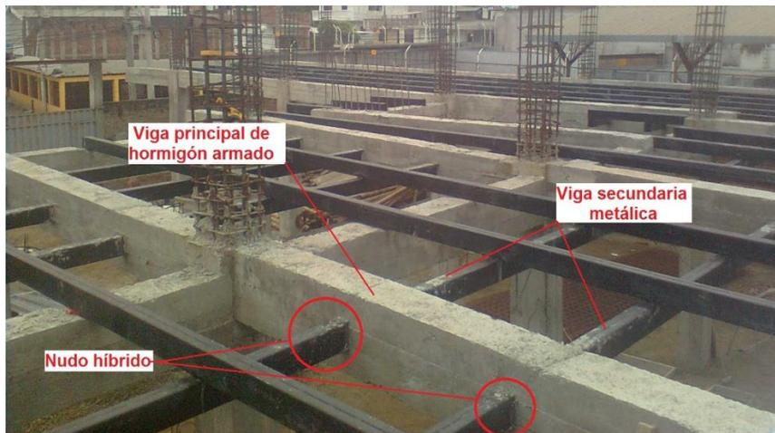
Figura 1. Viga de hormigón con viga de acero pasante.
